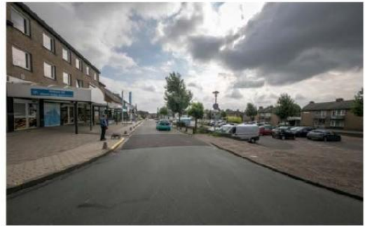
Dit stukje Kerkstraat in Hulsberg zal verdwijnen. De kuil rechts wordt opgehoogd. FOTO LUC LODDER
